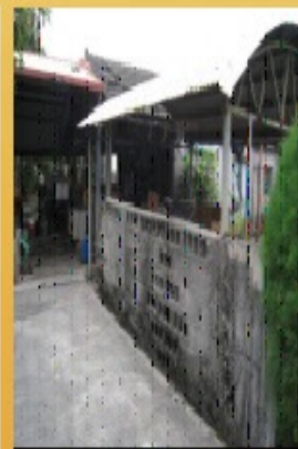
加蓋鐵皮屋及圍牆
